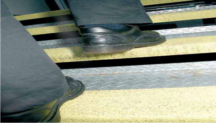
Şekil A.6.6: Kaymaz zemin kaplamalı merdiven örneği
